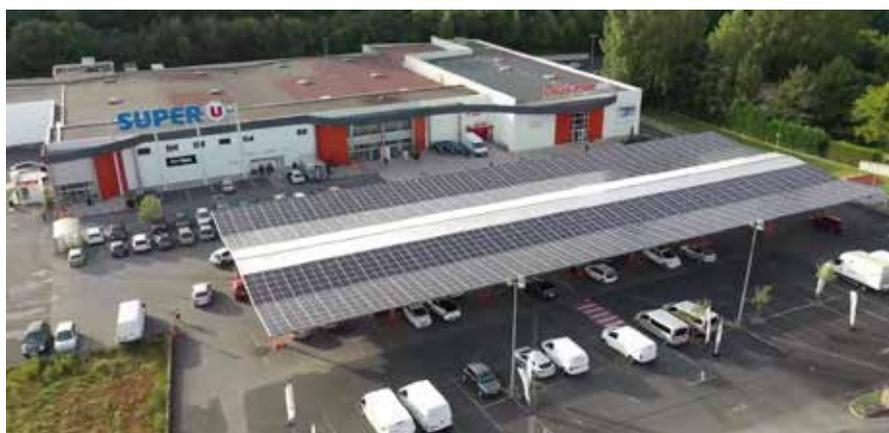
Les ombrières photovoltaïques représentent une surface de près de 1 600 m<sup>2</sup>. L'installation comprend 924 modules photovoltaïques pour une production de 309 kWc (kilowatt-crête).
