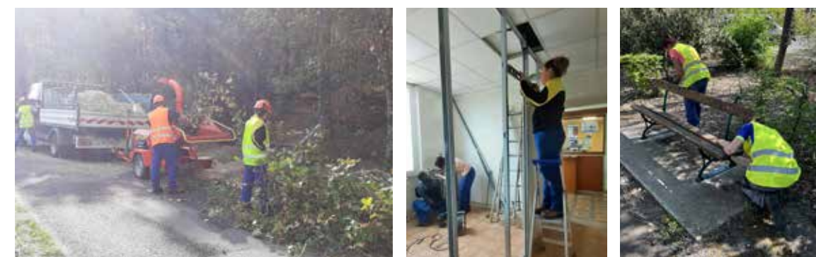
Broyage de branches et nettoyage de la voirie à Le Garric en novembre 2022 - Pose de placage et isolation des locaux de la mairie de Mirandol en décembre 2022 Restauration du mobilier urbain (banes et poubelles) des parcs du Candou et de Jean Jaurès à Carmaux en avril 2023
