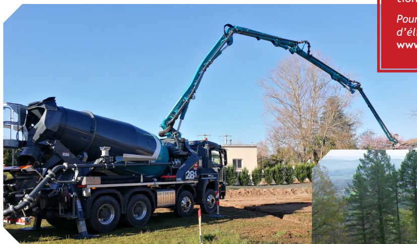
Ci-dessus : Livraison de béton prêt à l'emploi - Camion-pompe à béton
