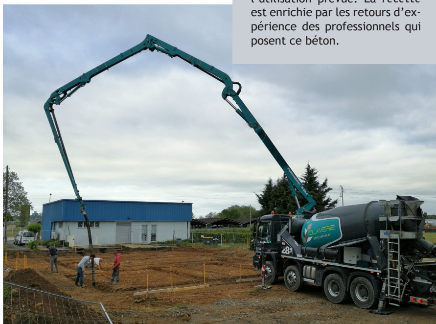
Camion-toupie et pompe à béton - Livraison de béton prêt à l'emploi sur un chantier
