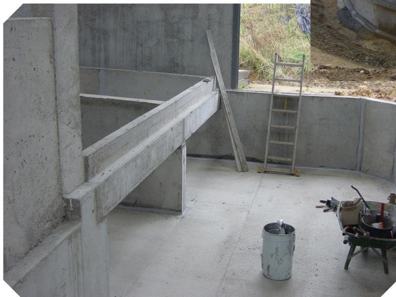
Ci-dessous : Eléments en béton préfabriqué pour un bâtiment d'élevage
