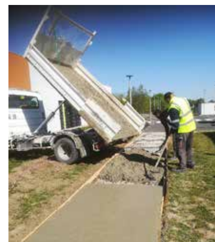
Construction d'une allée pour la crèche de Règuelongue
