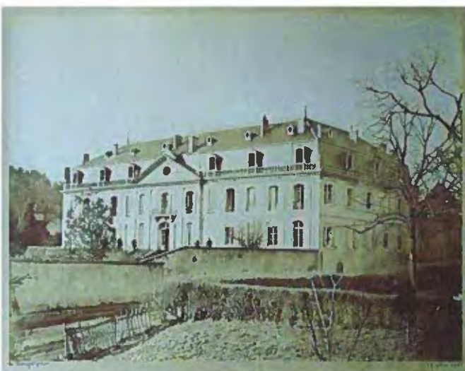
Fig. 15 - Vue générale du château depuis le nord-est prise en septembre 1881. H. Prompt (photographe) - collection particulière famille de Solages
