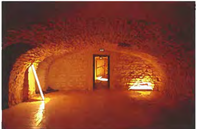
Fig. 8 - Voûte en pierre clavée en partie de l'orangerie, vestige de la halle.
