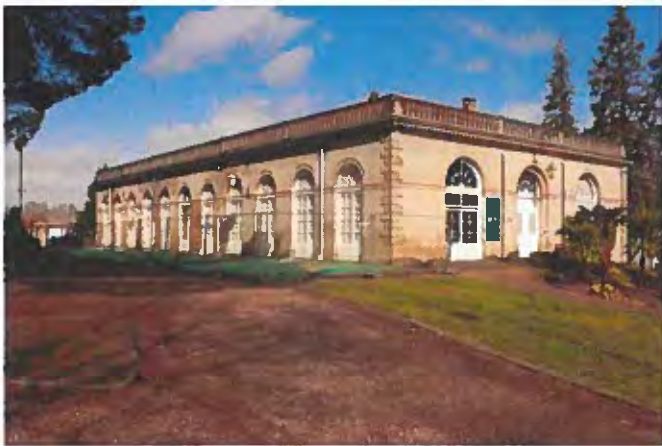
Fig. 7 - Vue générale depuis le sud-est de l'ancienne orangerie.
