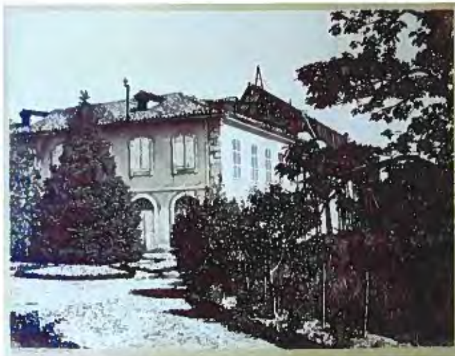
Fig. 9 - Photographie de 1881 de l'angle sud-est du château en travaux. H. Prompt (photographe) - Collection particulière de la famille de Solages
