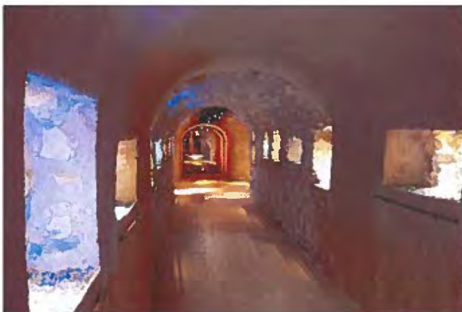
Fig. 9 - Couloir central du niveau de chauffe de l'ancienne halle.
