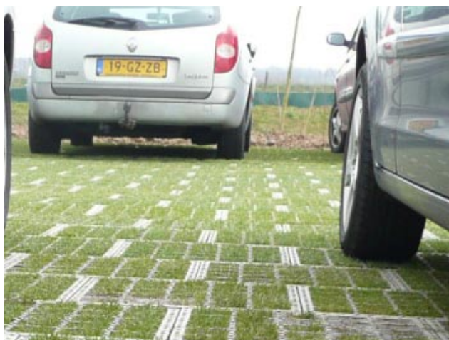
Les dalles engazonnées donnent l'assurance d'un revêtement stable, propre à supporter le poids des véhicules, sans altérer la perméabilité du sol.
