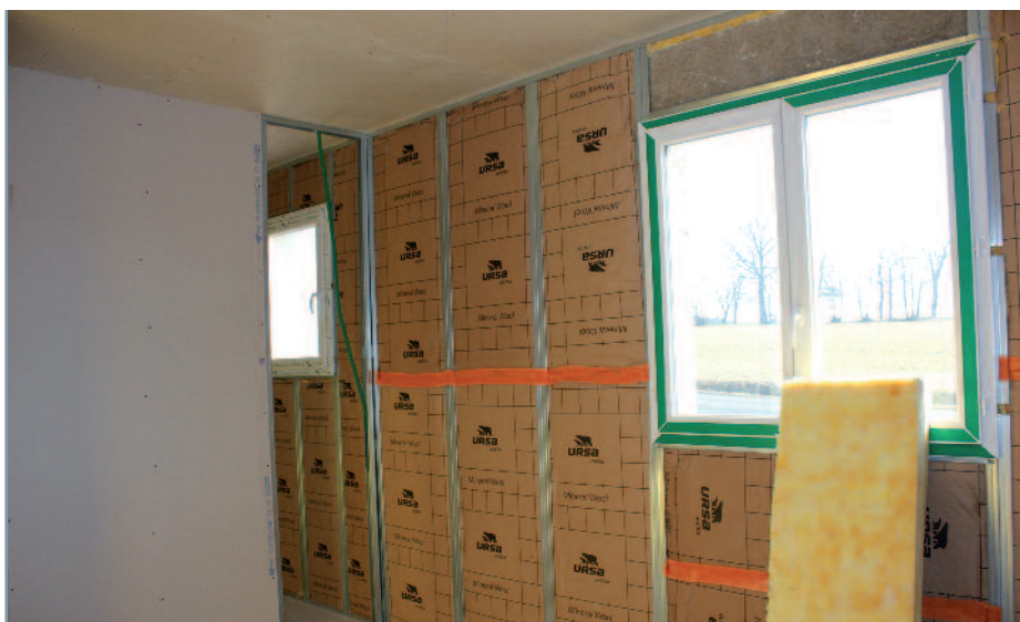
Isolation intérieure (murs et combles).
