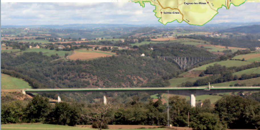
Les viaducs ferroviaire et routier de Tanus.
