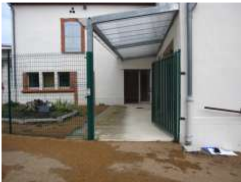
Entrée du bâtiment
